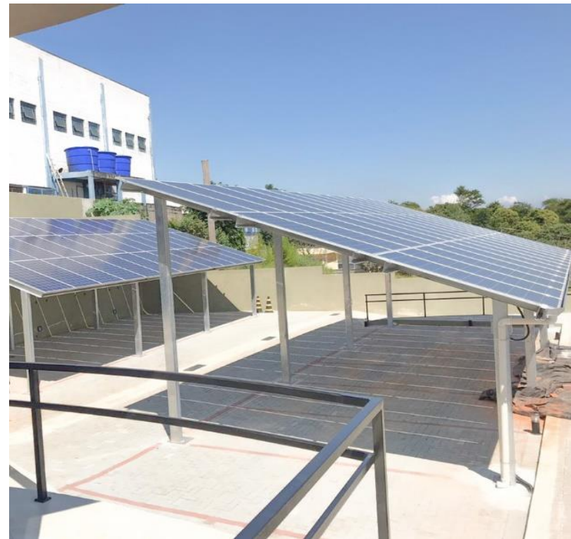
Instalação de placas solares em algumas unidades
